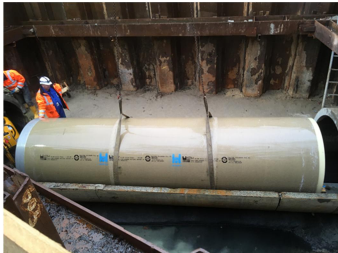
Abbildung 2: Relining / Einzelrohrlining mit GFK-Rohren
