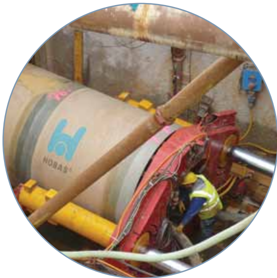
Vortrieb von besonders leistungs- starken HOBAS Rohren
