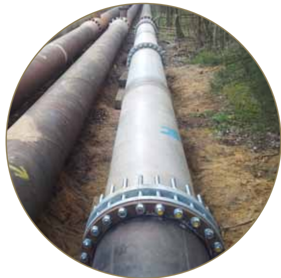
Hochabriebsbeständiges Druckrohr, Polen 2014
